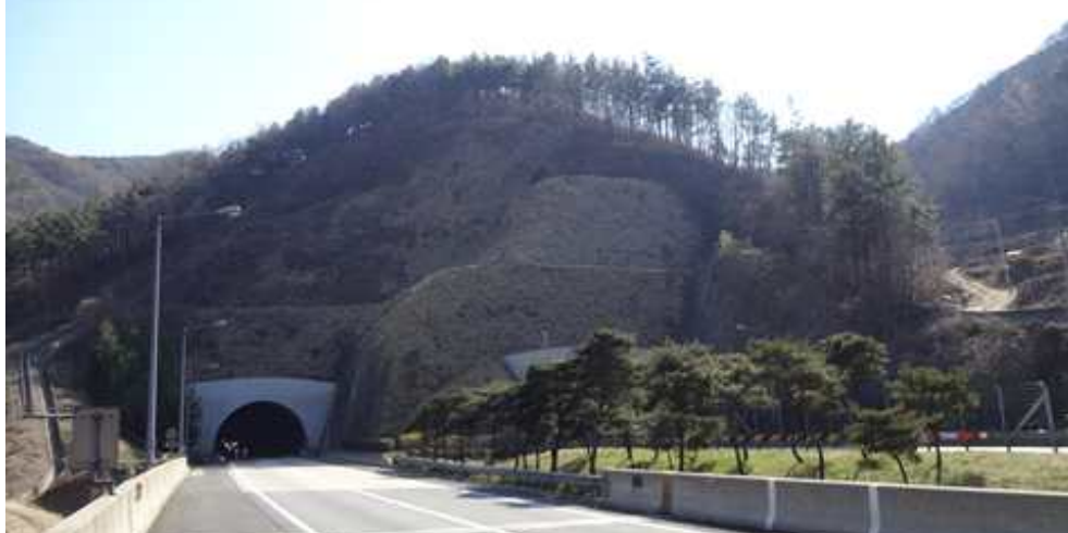
부산절토 71 (부산기점 70.40km / 4공구 청도2터널 종점부 STA.6+060)
