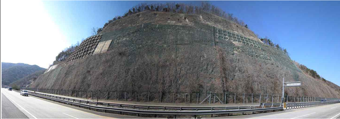
부산절토 15 (부산기점 70.77~71.01km / 4공구 STA.5+450~5+690)
