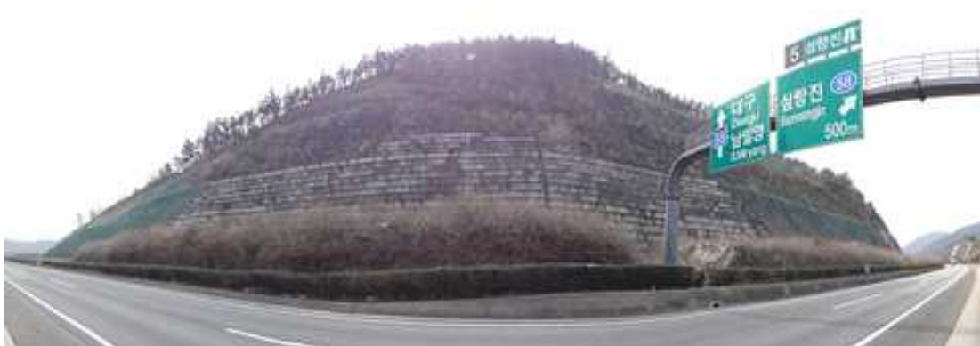
부산절토 7 (부산기점 30.75~31.16km / 9공구 STA.1+740~2+150)
