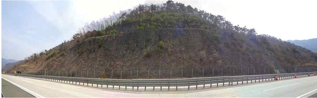
부산절토 36 (부산기점 23.84~24.03km / 9공구 STA.8+870~9+060)
