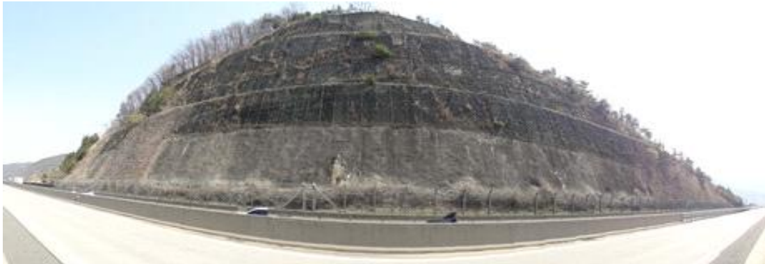
대구절토 13 (부산기점 59.27~59.65km / 5공구 STA.5+100~5+480)
