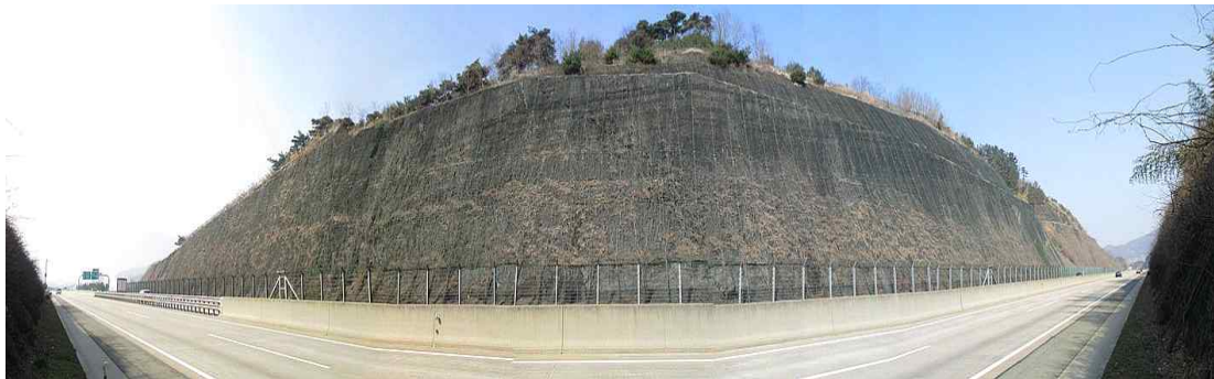
부산절토 14 (부산기점 65.94~66.24km / 4공구 STA.10+220~10+520)
