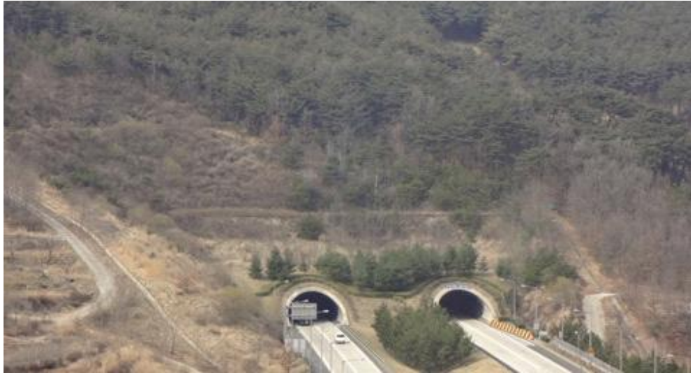
부산절토 67 (부산기점 51.92km / 7공구 고정3터널 시점부 STA.0+660)
