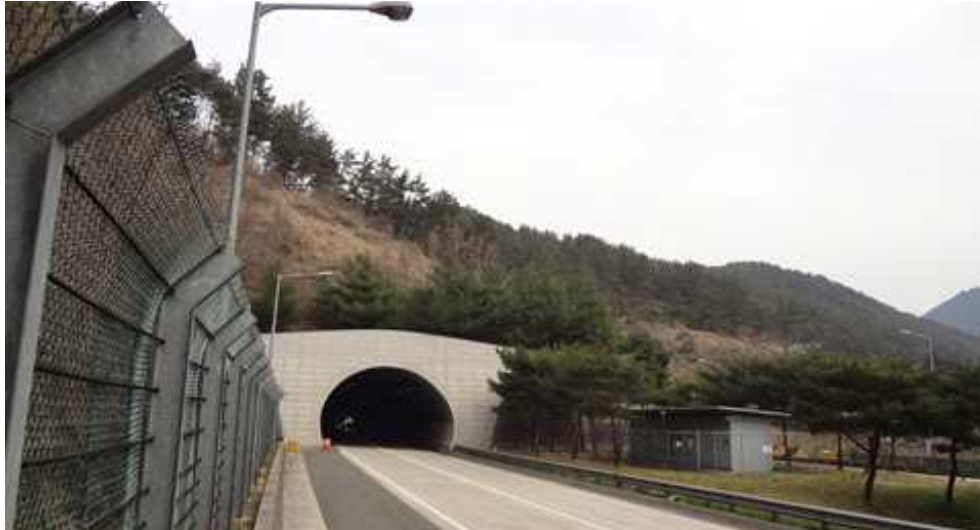
부산절토 62 (부산기점 42.50km / 7공구 가곡터널 시점부 STA.10+140)
