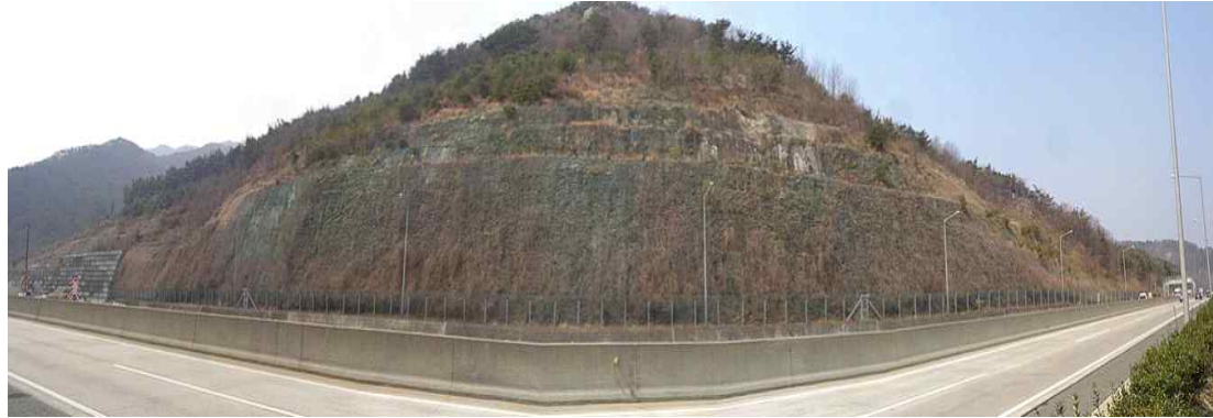
부산절토 4 (부산기점 12.97~13.23km / 10공구 STA.8+400~8+660)
