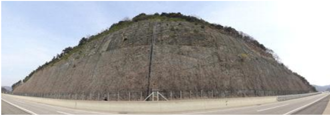
대구절토 17 (부산기점 72.74~73.12km / 4공구 STA.3+340~3+720)
