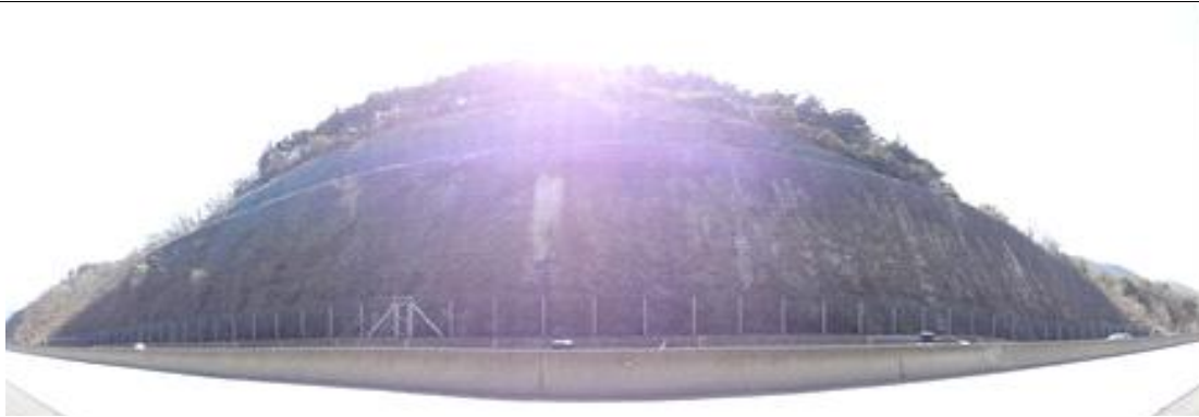
부산절토 51 (부산기점 82.19~82.42km / 2공구 STA.8+830~9+060)
