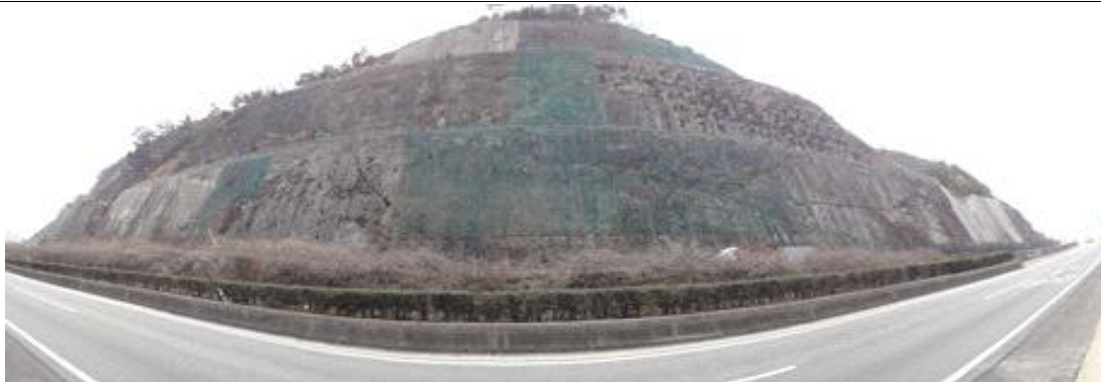
부산절토 8 (부산기점 31.16~31.36km / 9공구 STA.1+540~1+740)
