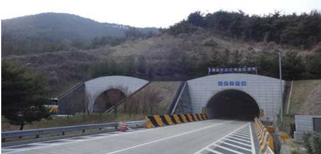
부산절토 61 (부산기점 33.27km / 8공구 삼랑진터널 시점부 STA.9+125)
