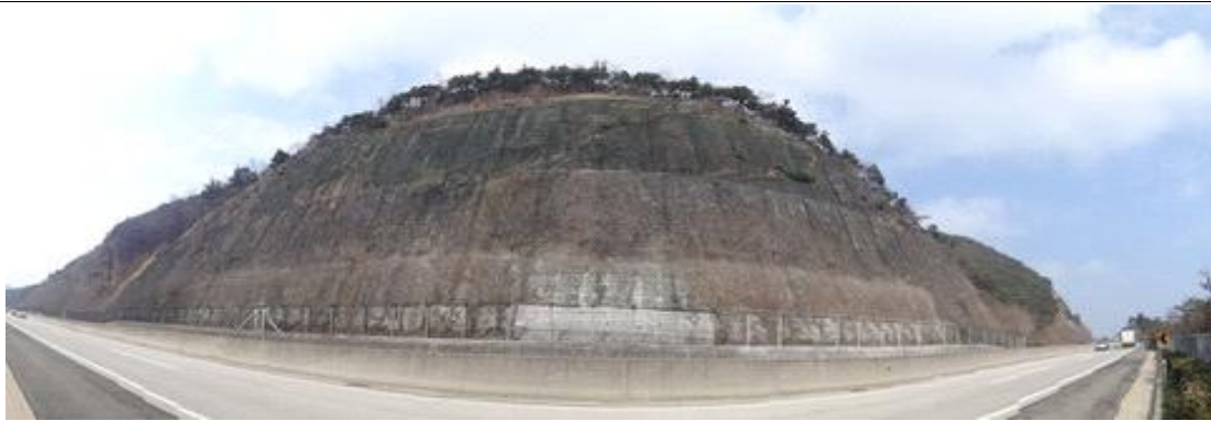
부산절토 22 (부산기점 81.14~81.35km / 3공구 STA.9+900~10+110)
