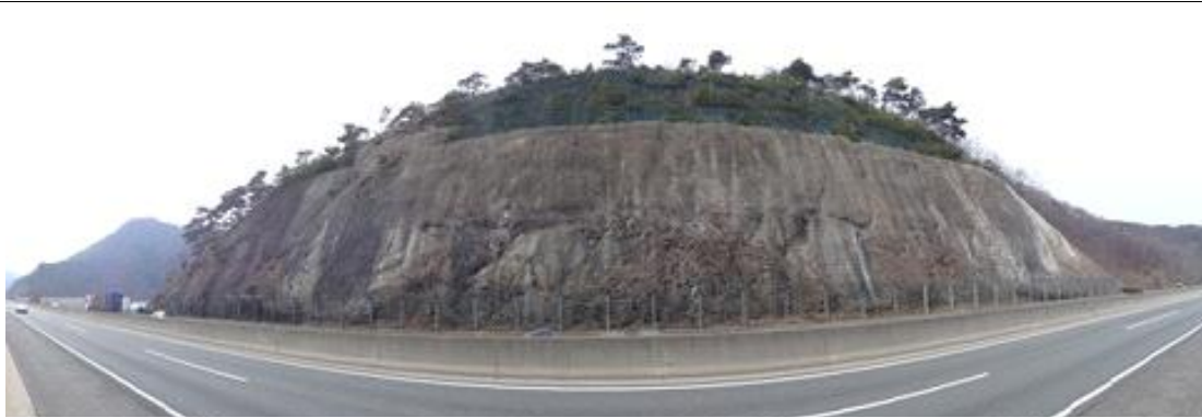
부산절토 31 (부산기점 19.82~19.98km / 10공구 STA.1+650~1+810)
