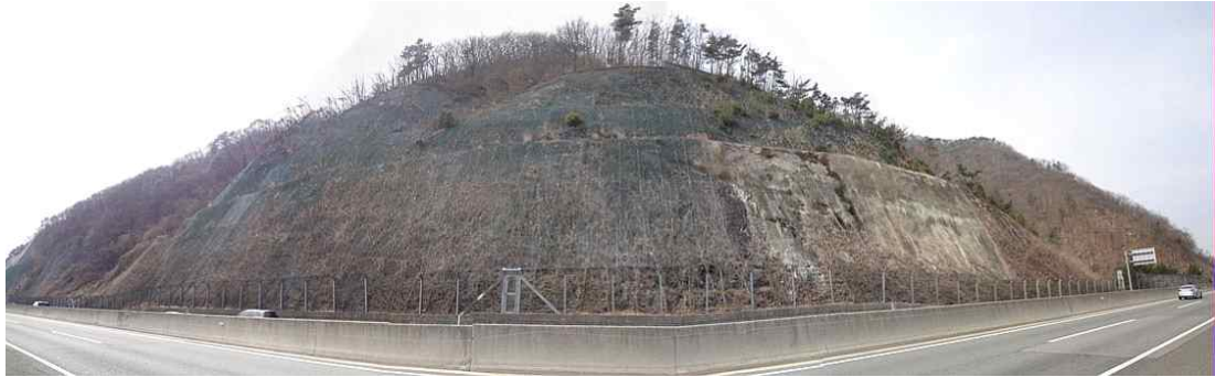
부산절토 34 (부산기점 21.21~21.40km / 10공구 STA.0+230~0+420)
