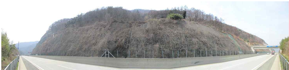
부산절토 44 (부산기점 71.01~71.20km / 4공구 STA.5+260~5+450)
