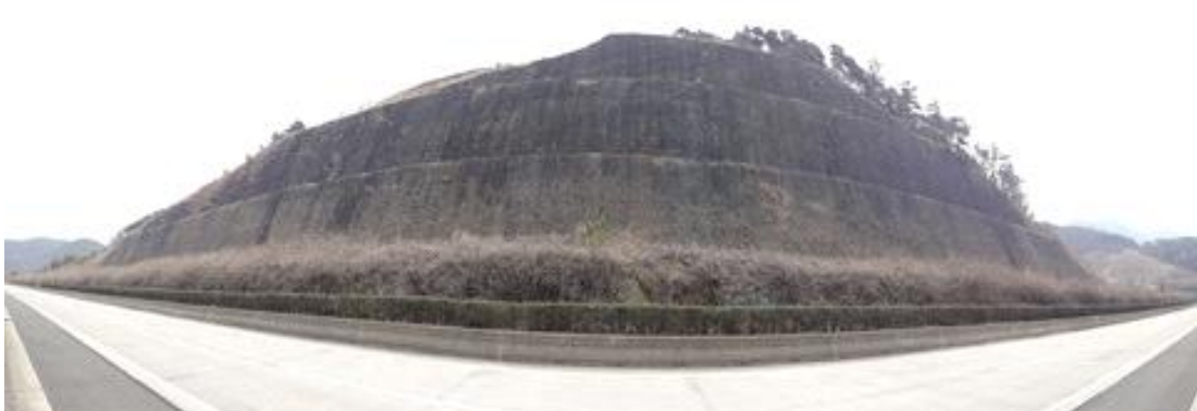
대구절토 6 (부산기점 27.73~28.09km / 9공구 STA.4+810~5+170)
