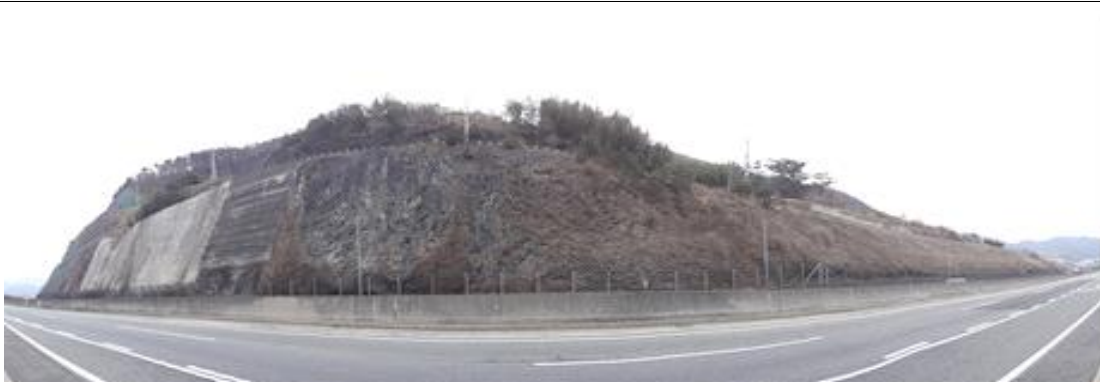
부산절토 38 (부산기점 31.36~31.73km / 9공구 STA.1+170~1+540)
