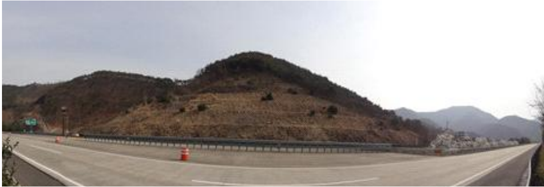
대구절토 37 (부산기점 28.84~29.00km / 9공구 STA.3+900~4+060)
