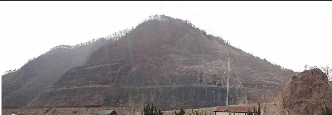
부산절토 5 (부산기점 21.92~22.28km / 9공구 STA.10+620~10+980)
