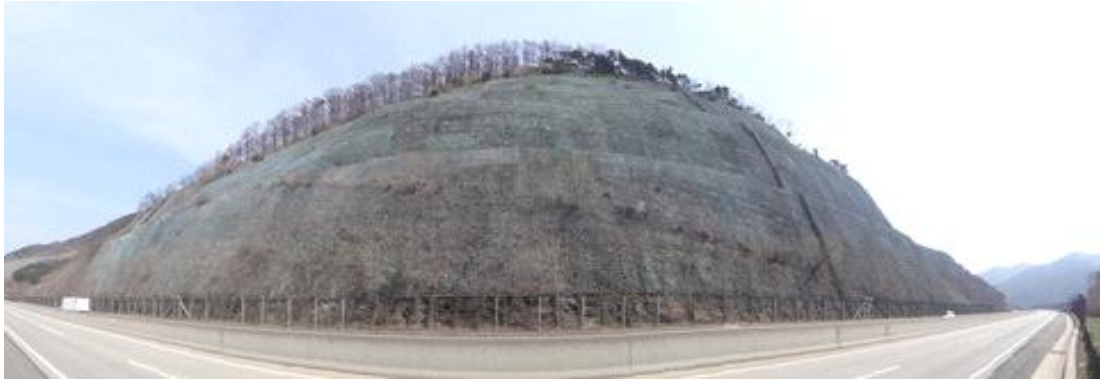
대구절토 18 (부산기점 73.38~73.78km / 4공구 STA.2+680~3+080)
