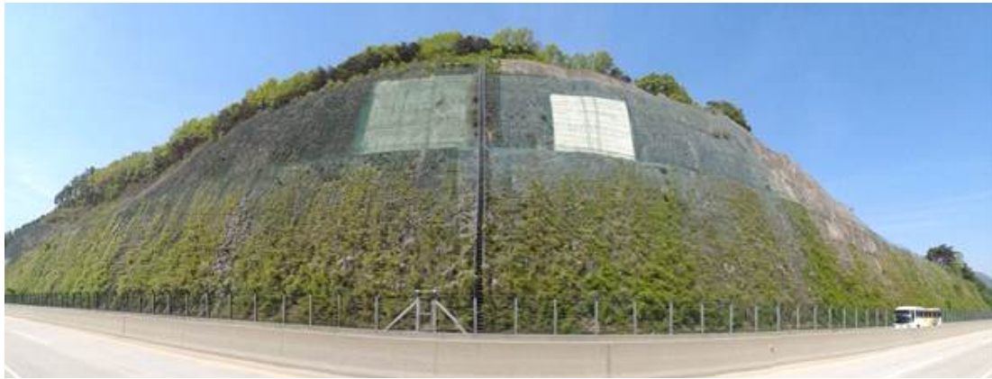
부산절토 16 (부산기점 71.58~71.86km / 4공구 STA.4+600~4+880)
