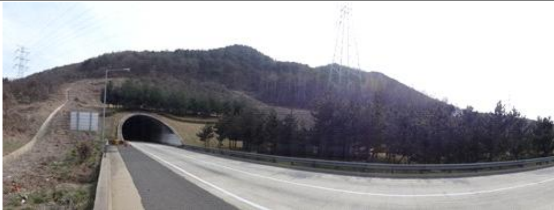
부산절토 68 (부산기점 52.56km / 7공구 고정3터널 종점부 STA.0+140)
