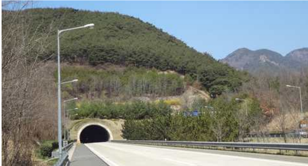
부산절토 64 (부산기점 48.75km / 7공구 고정1터널 시점부 STA.3+900)
