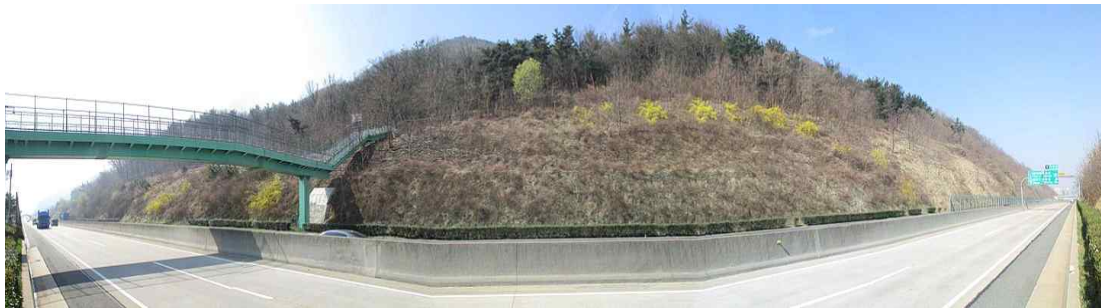
부산절토 52 (부산기점 83.31~83.94km / 2공구 STA.7+310~7+940)
