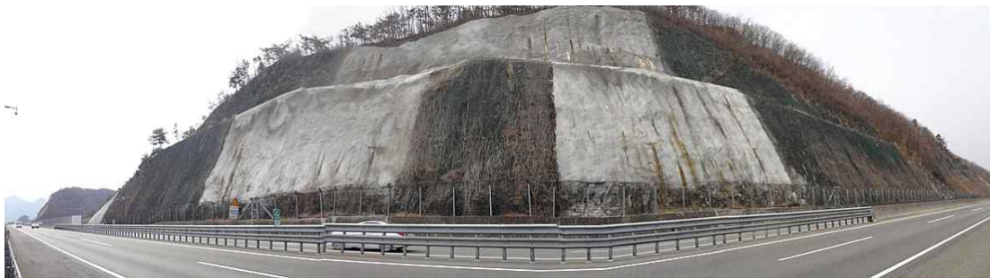
부산절토 33 (부산기점 20.87~21.13km / 10공구 STA.0+500~0+760)
