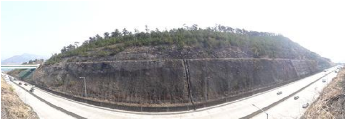
대구절토 2 (부산기점 10.56~11.21km / 10공구 STA.10+420~10+900)
